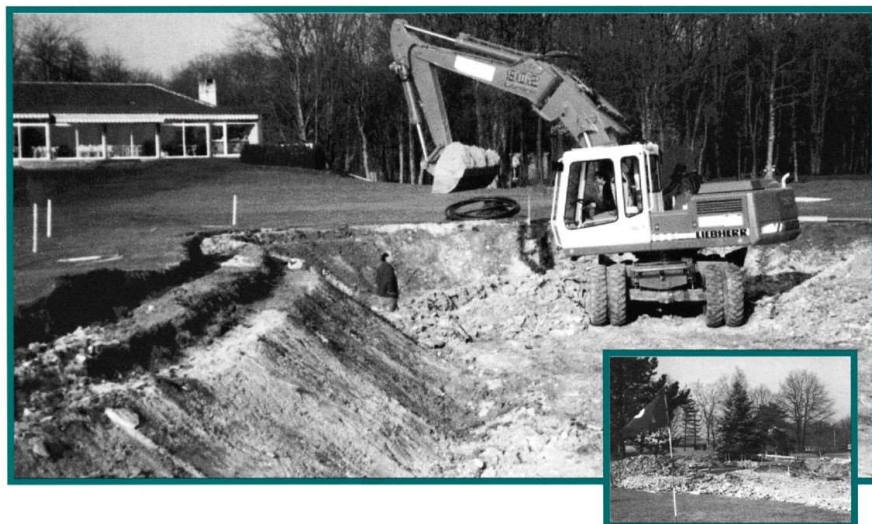
▼ Ouverture des tranchées
